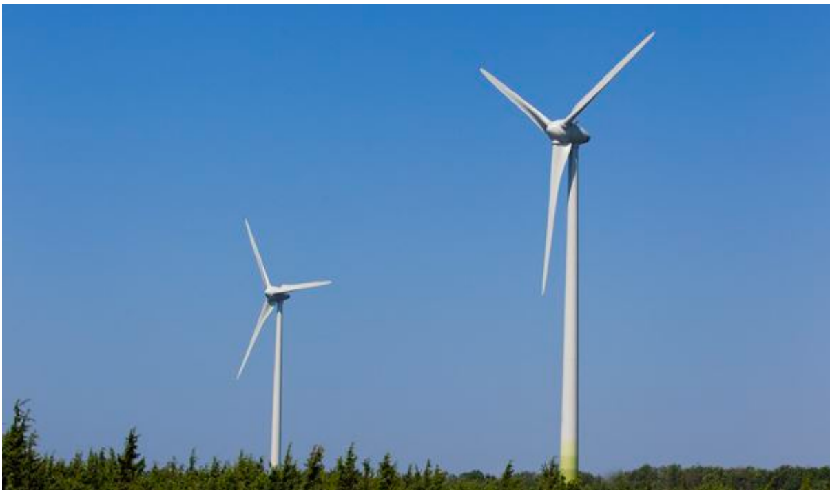
Foto 1.3.1.1 Kolmelabaline horisontaalteljega tuulik (allikas https://energiatalgud.ee/Elektrituulik#fn36 ).
